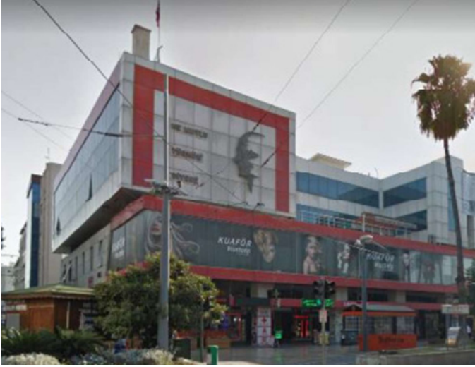
Şekil 3. Yenileme çalışmasından sonraki cephe (Dayı, 2019)
